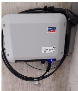
C'è una stazione di ricarica per auto elettriche nel garage. Si tratta di uno **SMA EV Charger** alimentato ad energia solare, compatibile con tutti i comuni veicoli elettrici grazie ad un cavo di ricarica di tipo 2 collegato in modo permanente.
